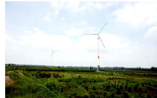
河南兰考分散式风电场位于农田内，机组变压器采用塔架内置模式，在降低建设成本的同时减少耕地占用，具有环境友好、节能环保的特点。
