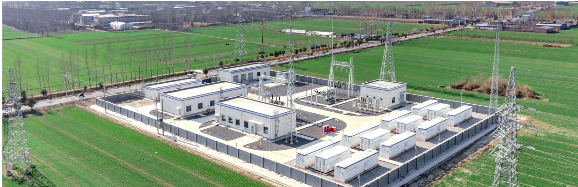
天润新乡延津项目是国家能源局2019年度公布的第一批风电平价上网示范项目。项目使用25台金风科技风电机组，总装机容量100MW，同期建设一座110kV升压站。自工程开工建设至竣工投产，采用国家重点节能低碳技术5项；建筑业“十项”新技术7大项8子项；电力建设“五新”推广应用10项，自主创新技术8项。通过了新技术应用专项评价。共获得专利6项、科技进步成果4项、QC成果6项、工法2项，荣获电力行业优秀工程设计三等奖。
