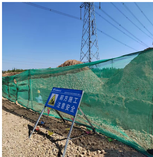
施工开挖拦挡
