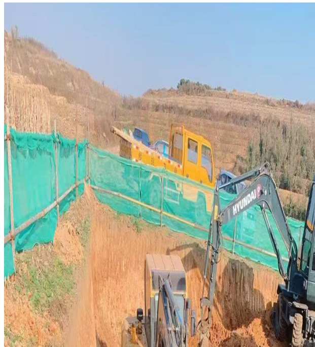
施工开挖拦挡
