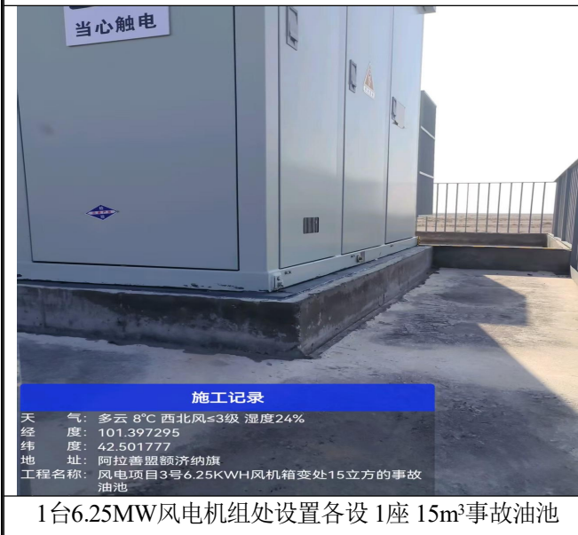
2台6.7MW风电机组处设置各设 1座 15m 3 事故油池
