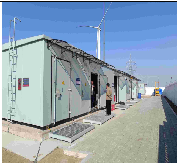
升压站透水砖铺装 拍摄日期 2025.3.19
