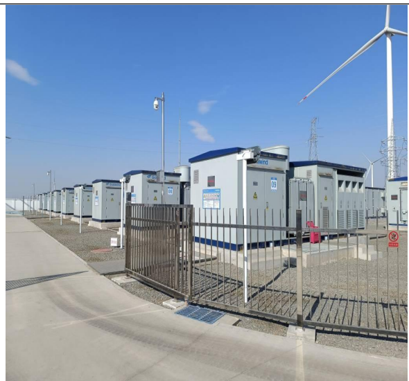
升压站碎石铺盖 拍摄日期 2025.3.19
