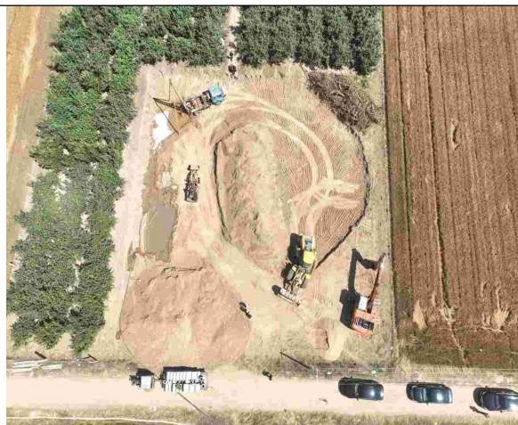
风机及箱变区表土剥离 拍摄日期 2024.6.29
