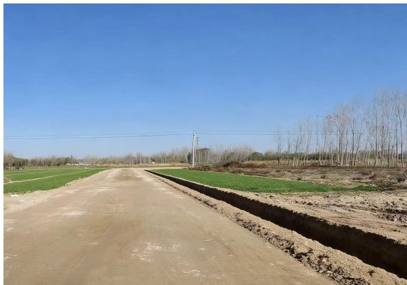
施工检修道路临时排水沟 拍摄日期 2024.4.10
