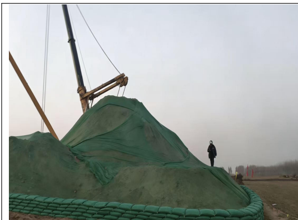
临时堆土密目网苫盖及拦挡 拍摄日期 2024.11.19
