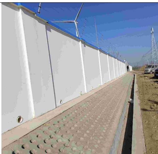
升压站排水沟及镂空砖护坡 拍摄日期 2025.3.19
