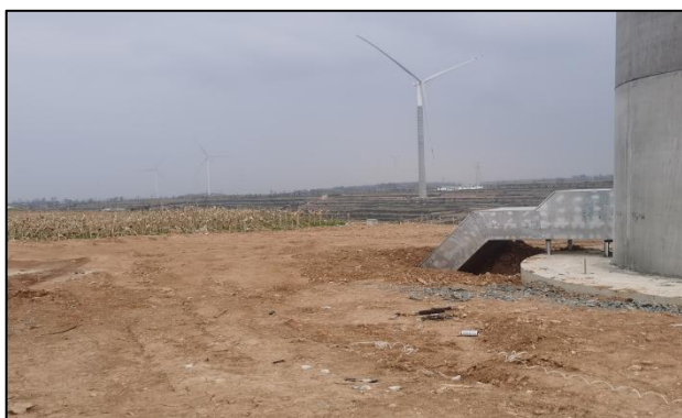
集电线路区恢复照片（草籽已播种暂未出）
