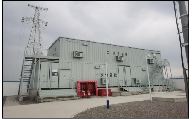
开关站内部照片
